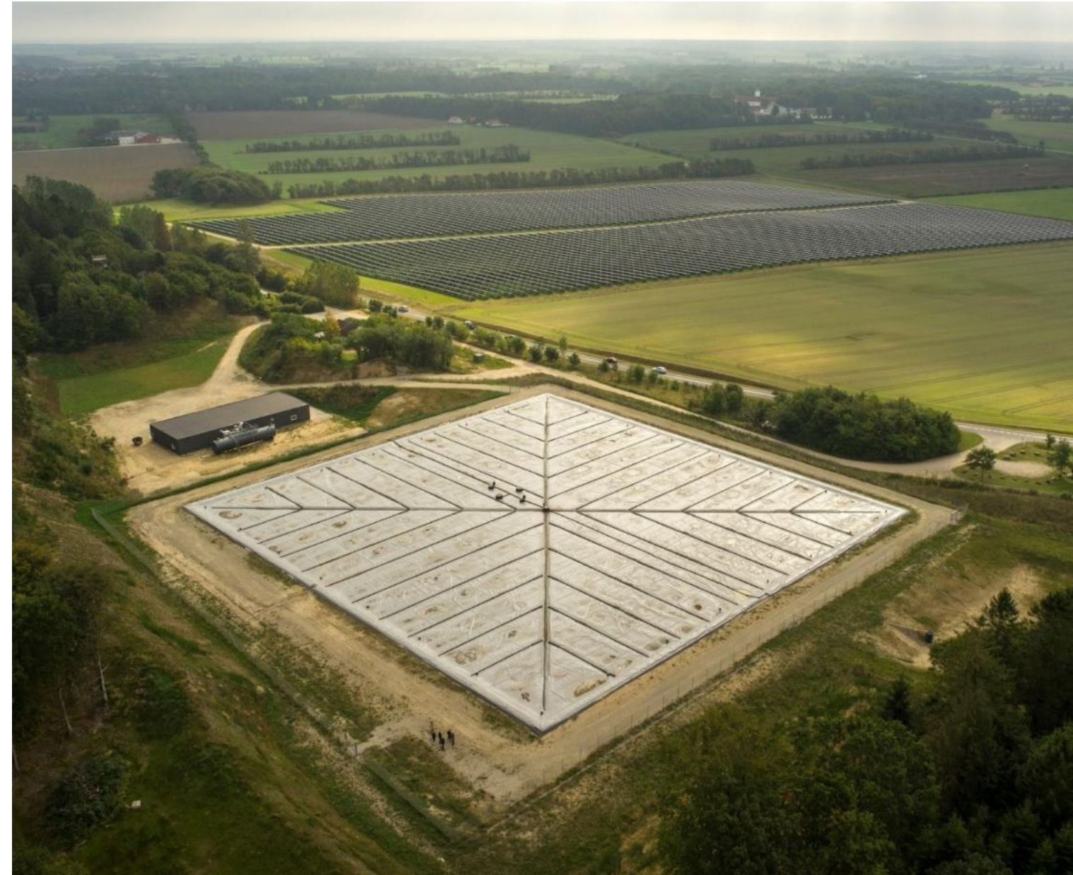
Photo aérienne de la centrale solaire et du PTES de Dronninglund Fjernvarme - PlanEnergi
