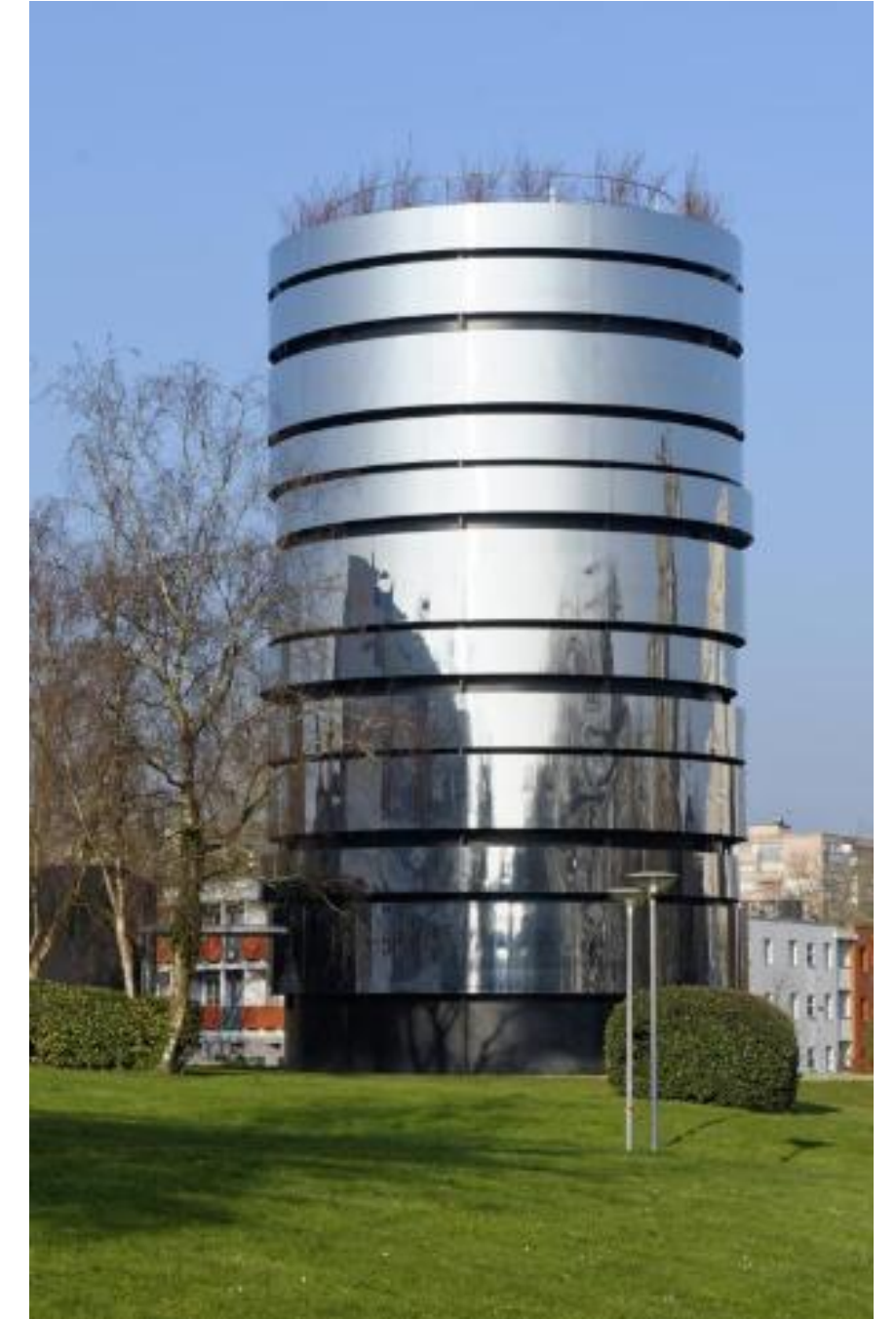
TTES à Brest – éco chaleur de brest, 1'000 m 3
