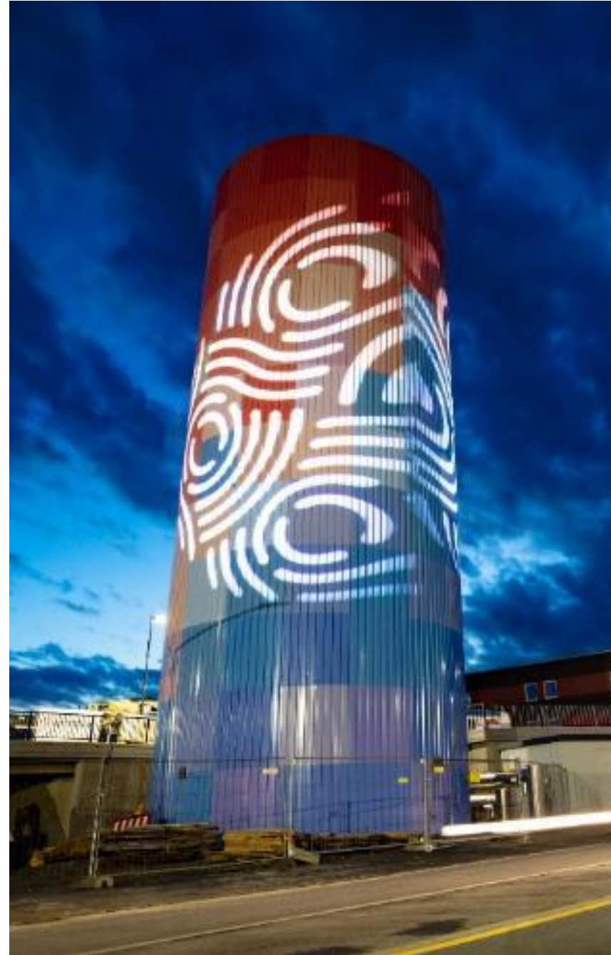
TTES à Detmold (Allemagne) – Stadtwerke Detmold, 1'850 m 3
