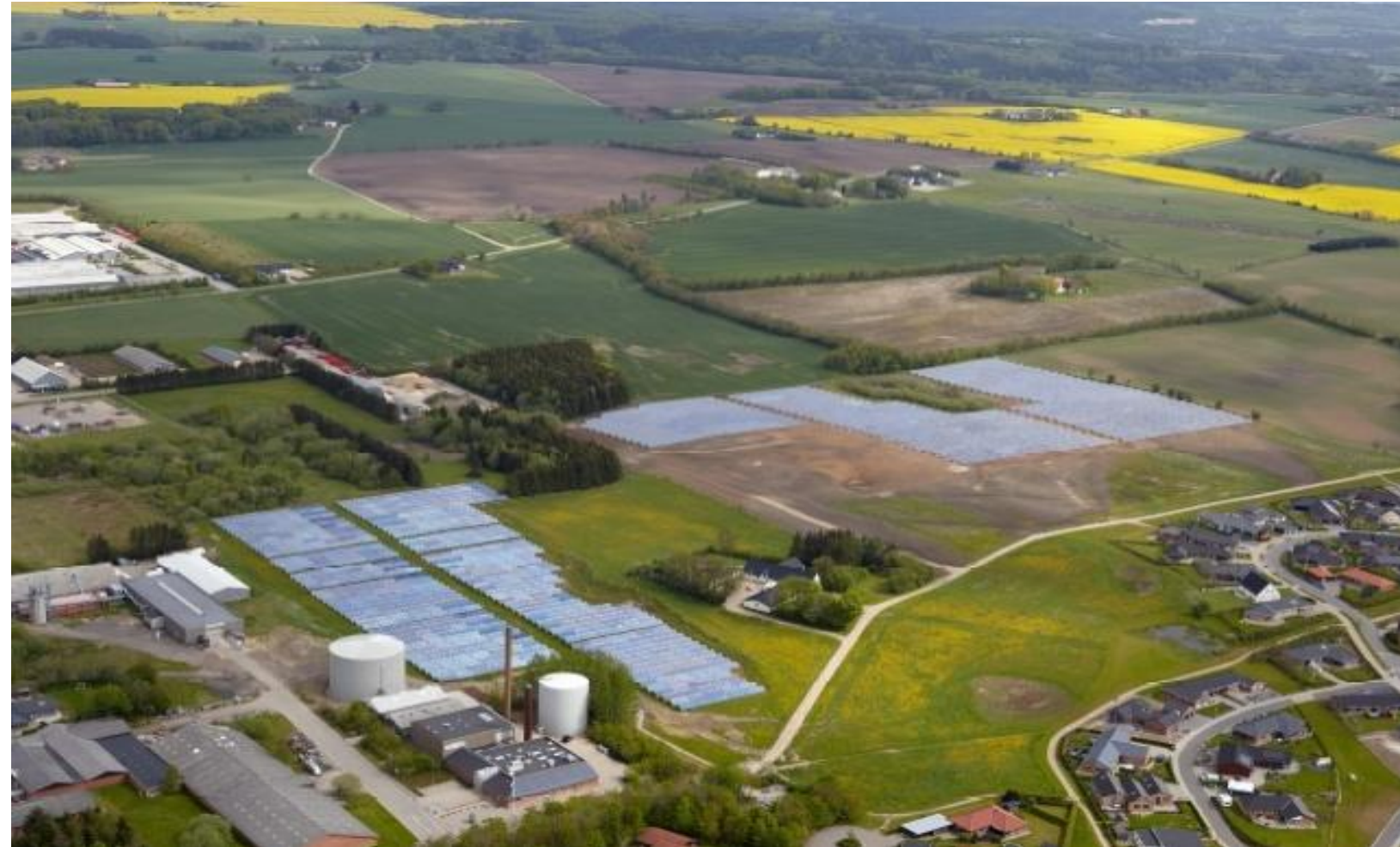
Photo aérienne de la centrale solaire et du stockage thermique - Brædstrup Fjernvarme
