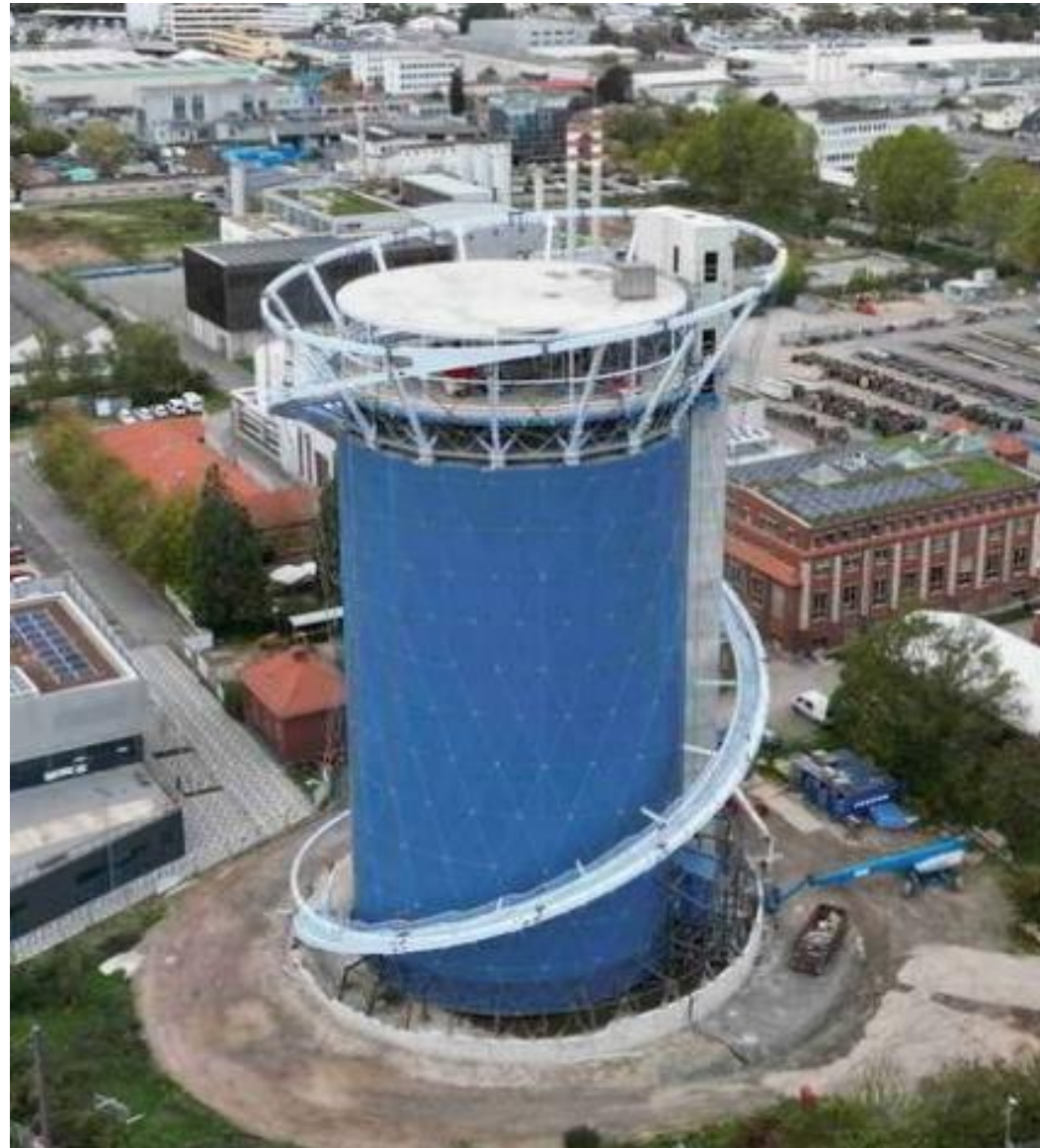
TTES de Stadtwerke Heidelberg (DE) 19'980 m 3 (stockage en deux-zones [*])
