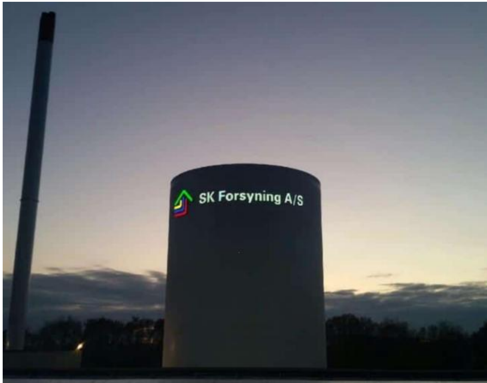
TTES de 6.000 m 3 à Slagelse, Danemark (SK Varme) Photo: Steeltank A/S
